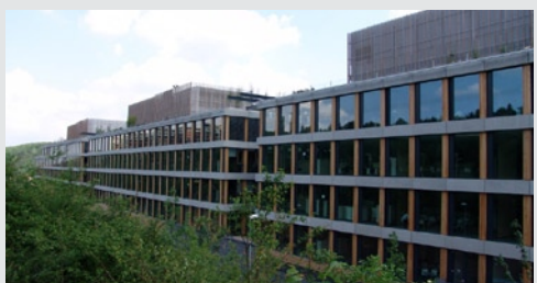
Josef Pleskot: Ústředí ČSOB Group, Praha–Radlice , 2006–2007.
